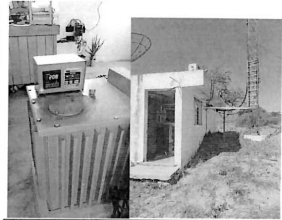
Limpieza de regulador y se verifica en estado de la torre de FM y retenidas.
