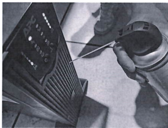
Limpieza del UPS
