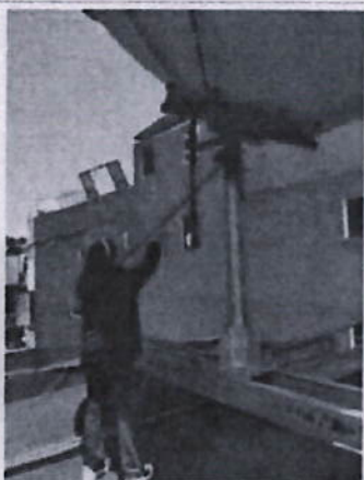
Se realizó limpieza de antenas satelitales
